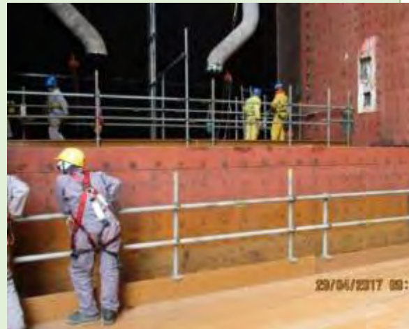
Edge Protection (Hard Barricades)
